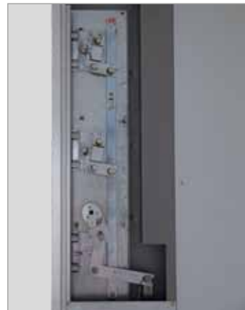
Dispositivo salida de emergencia
